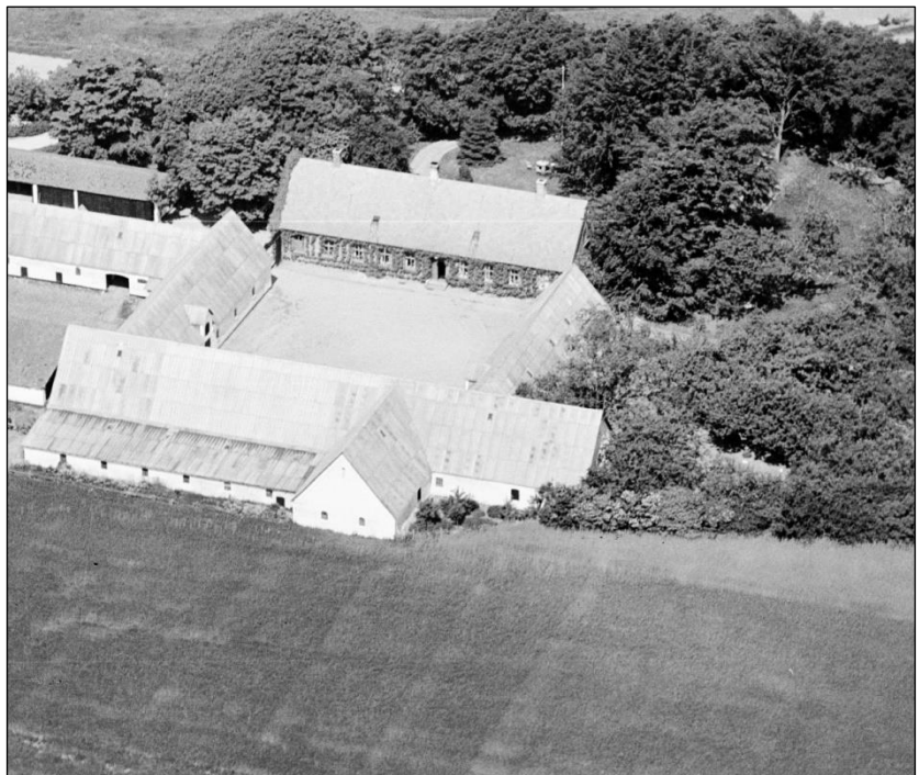
Engbækgård 1939. Her ses den oprindelige gård som Anders Rasmussen opførte efter branden i 1876.
