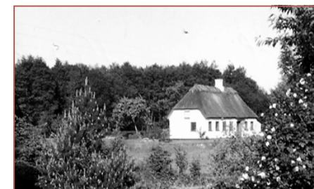
Remset 6, matr. 23g. Foto fra 1950-erne. I dag er der bygget en garage foran huset. Denne er også tækket med strå.
