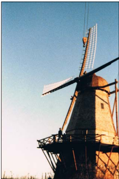
1988. Så er møllevingerne ved at blive sat på plads efter den omfattende reovering af møllen
